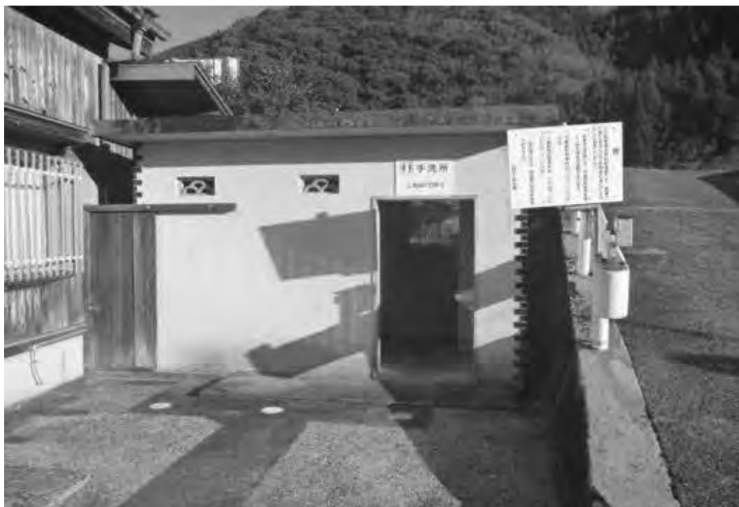
トイレの現況（男女共用）
