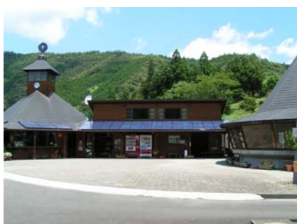
ウエル花夢管理棟
