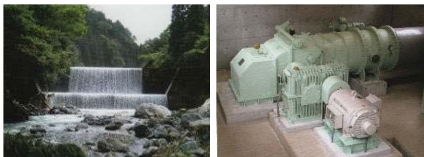
熊本県清和村発電所（砂防堰堤を取水堰として利用）
