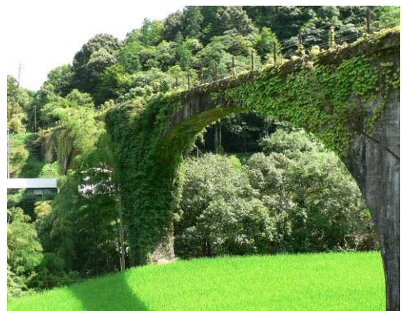
旧大正林道佐川橋
