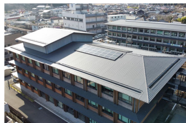
太陽光発電設備（本庁舎）
