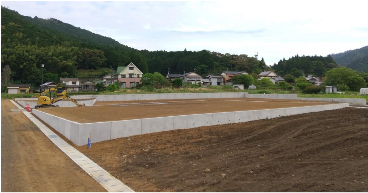
L型擁壁工全景
