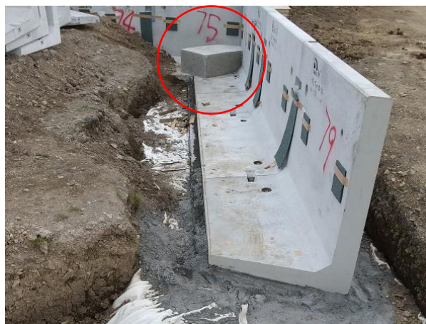
屈曲部の現場打による補強状況
