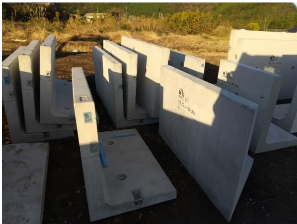
現場に搬入されたプレキャストL型擁壁
