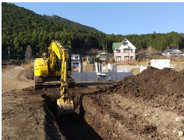
床掘作業に丁張や補助作業員が不要
