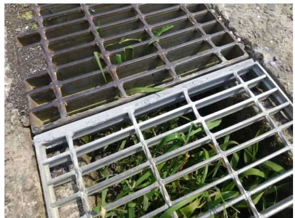
鉄板を溶接し受台に載るよう加工した。
