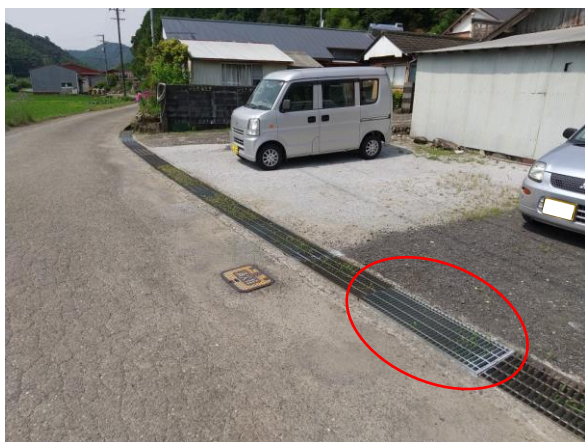
全景（応急対策後の状況）
