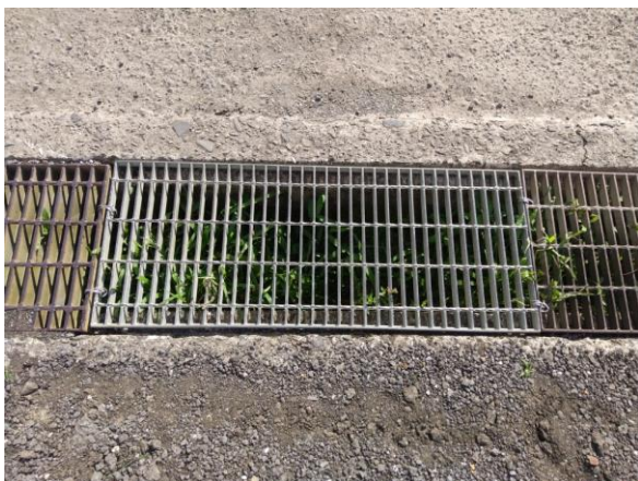
グレーチング蓋をステンレス線で連結。
