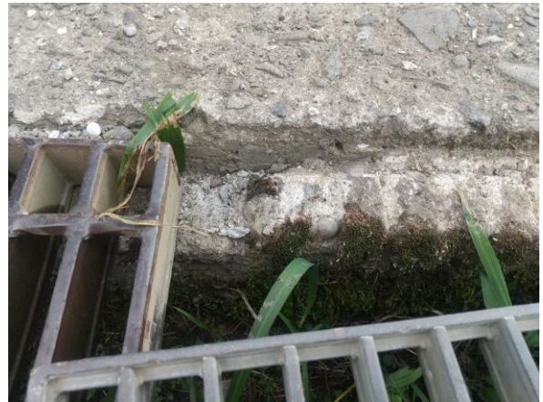
側溝の受台部が摩耗し、グレーチング蓋の端を踏むと跳ね上がりやすい状態だった。
