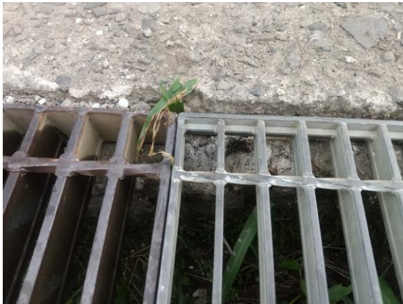
側溝の受台部が摩耗し、グレーチング蓋の端を踏むと跳ね上がりやすい状態だった。
