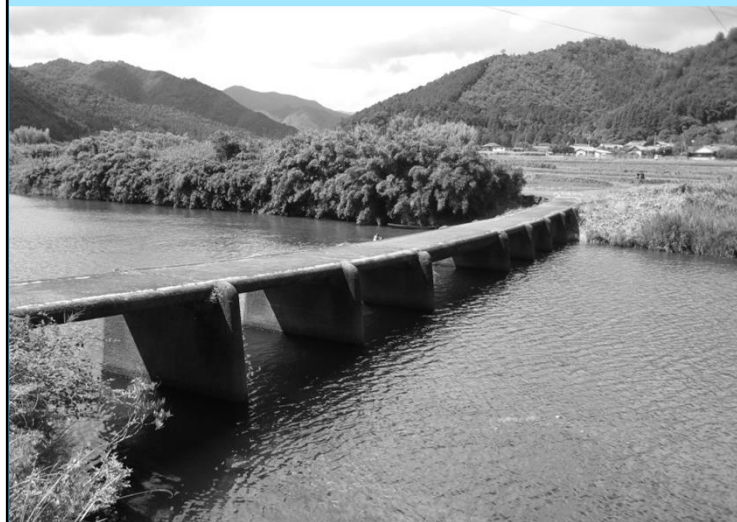
壺斗俵沈下橋
