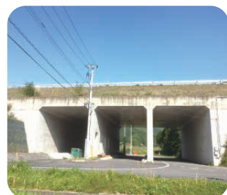
地区の真ん中を走る高知道との立体交差は、ため池が万が一決壊した場合に備えて、空間を大きくとっている
