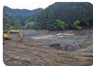
ため池は現在改修中
