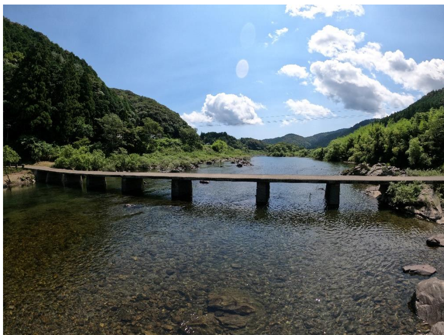
向弘瀬沈下橋（四万十町弘瀬）
