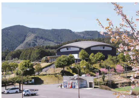
平成7年にオープンした窪川四万十会館
