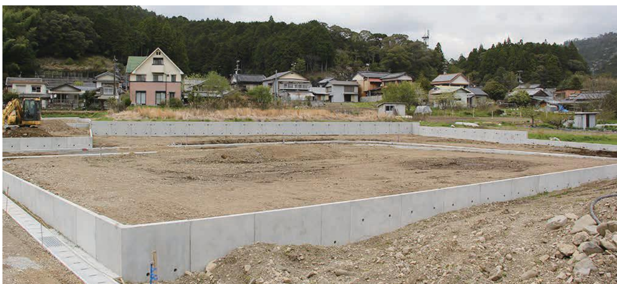
定住住宅米奥団地の建設予定地
