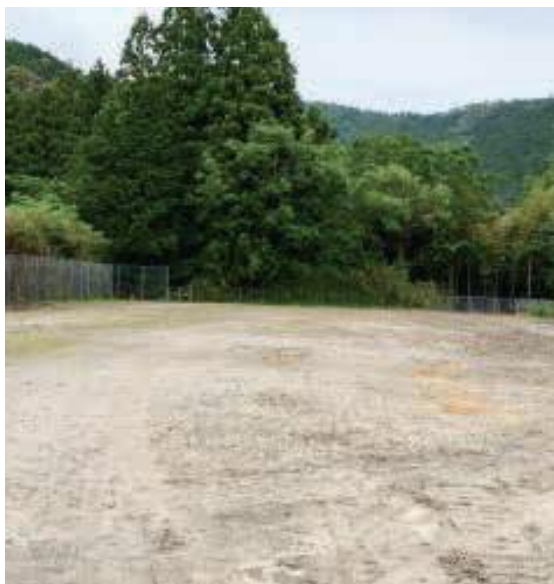
松葉川地区基幹集落センター工事場所
