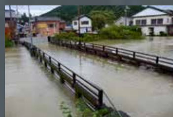
吉見川の増水により冠水した吉見川橋。
