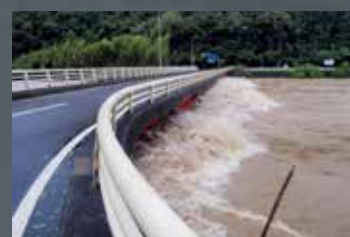
打井川橋の橋桁に迫る四万十川の濁流。
