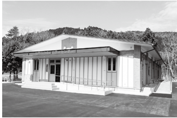
四万十ヒノキが使用された平屋建てのコミュニティセンター
