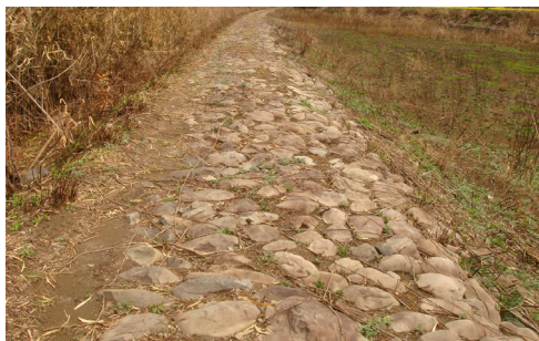
石積み堤防（市生原）
