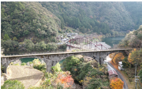
旧森林軌道の橋梁（下津井）
