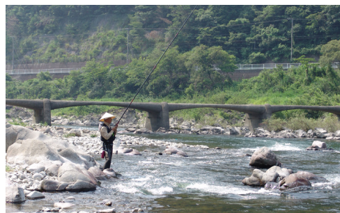
上岡沈下橋（上岡）
