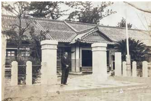
立派な門と重厚な造りの旧校舎 (昭和10年)
