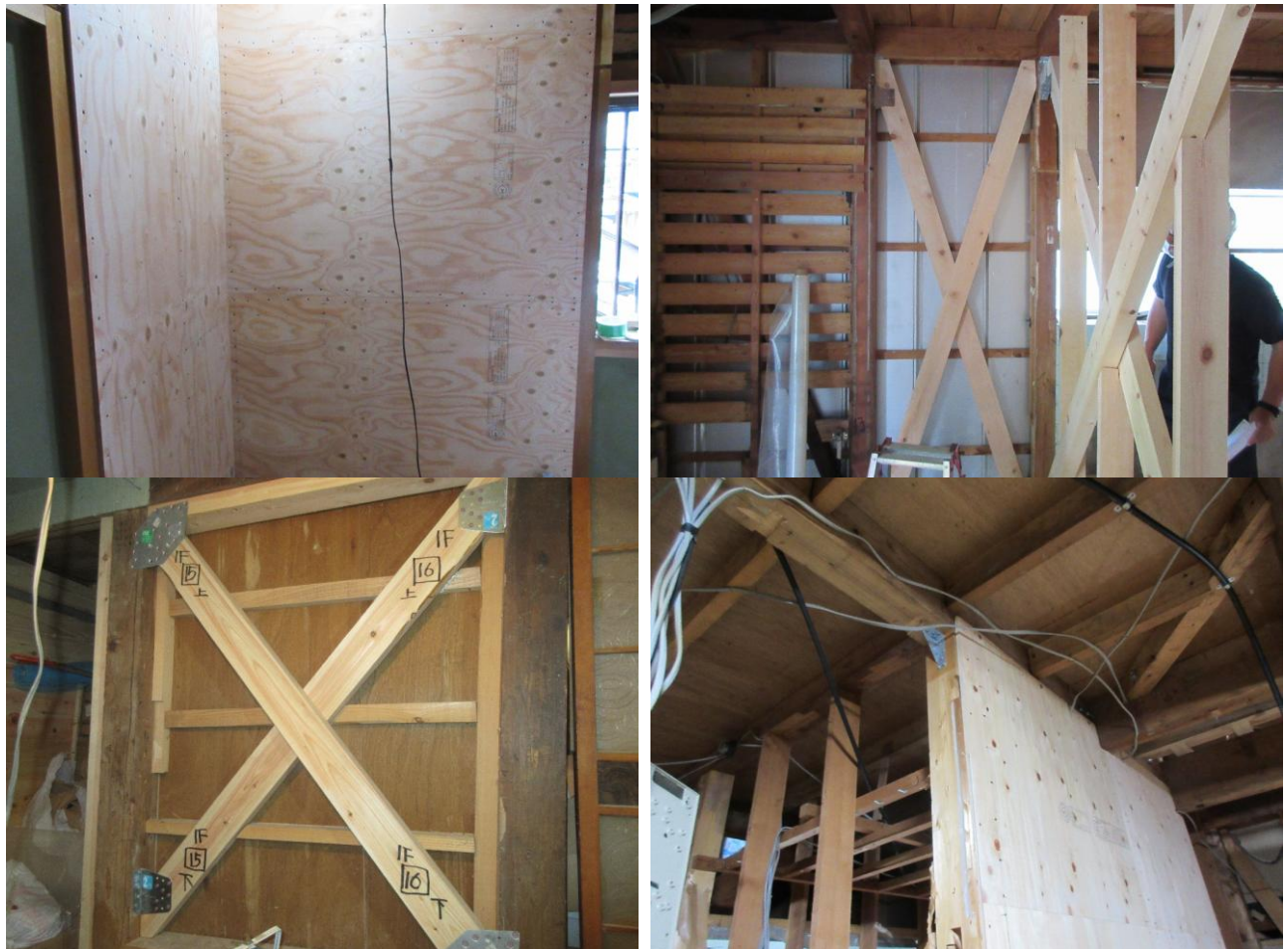
図表 59 耐震改修工事の例
