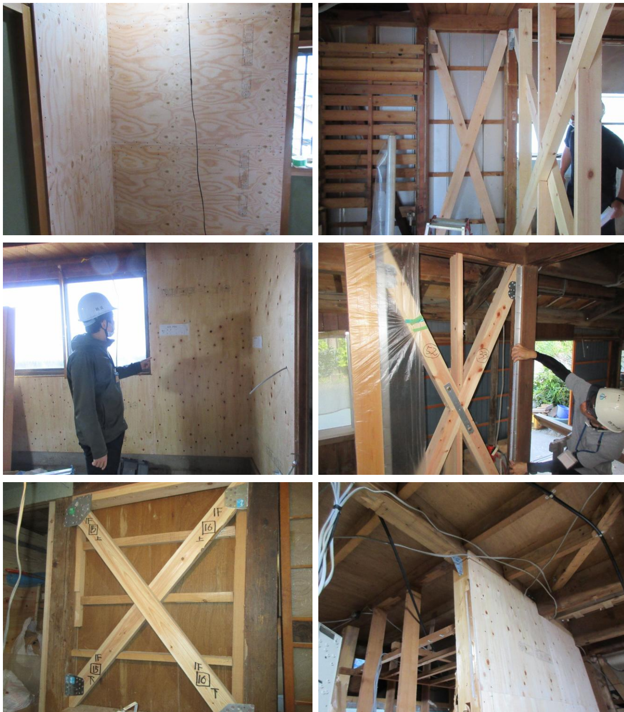
図表 59 耐震改修工事の例
