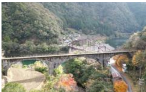
旧森林軌道の橋梁（下津井）
