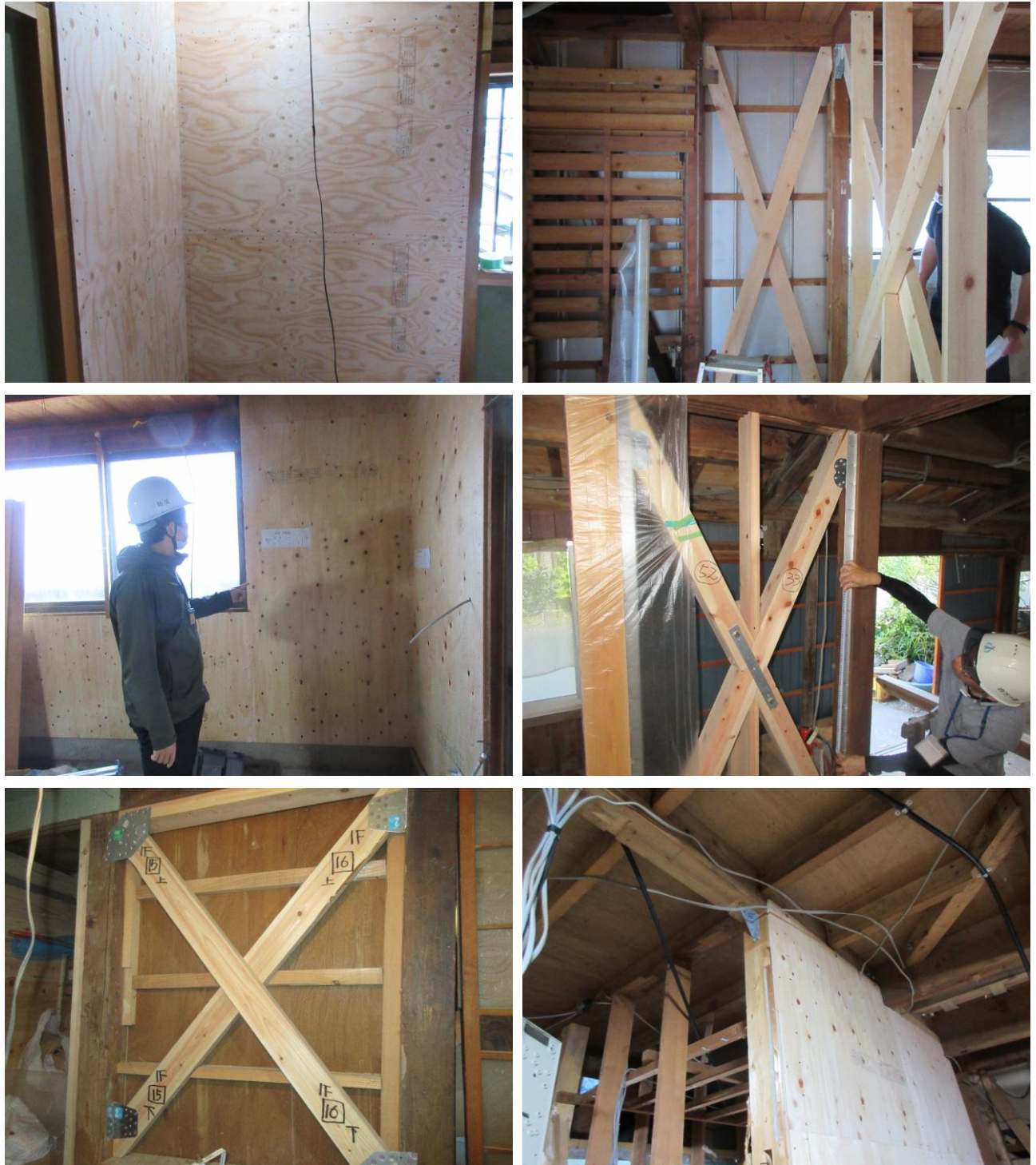
図表 57 耐震改修工事の例
