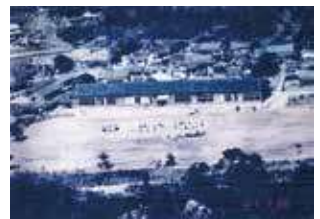
1951(昭和26)年に建った校舎
