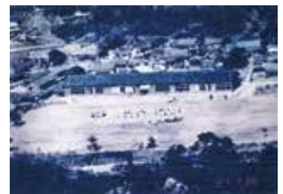
1951(昭和26)年に建った校舎
