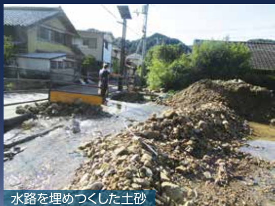
農地へ流れ込んだ大量の土砂
