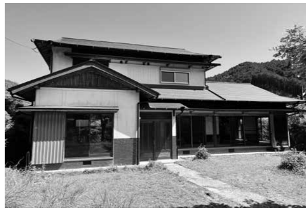
窪川中津川に整備された中間管理住宅
