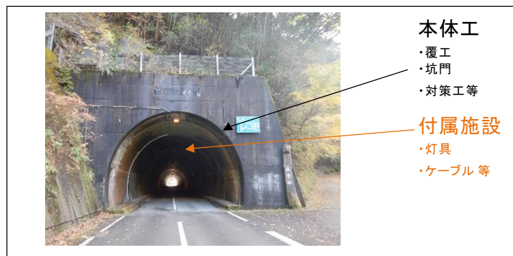
図-2 トンネル構造
