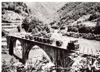
下津井佐川橋
