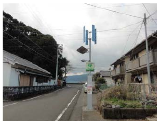
避難誘導標識
