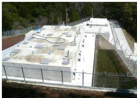
浄水池・配水池
