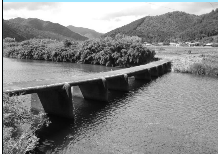
壺斗俵沈下橋
